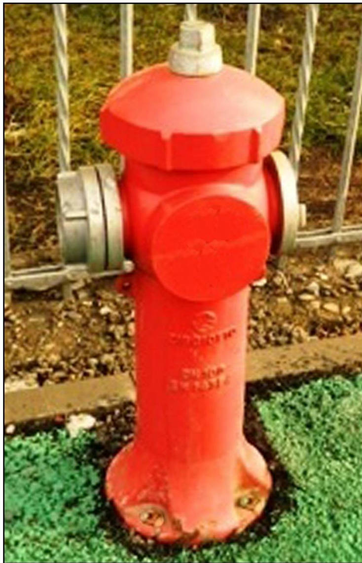
Hidrant de incendiu
